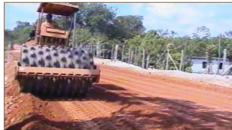
Imagem 6: Compactação com rolo carneiro.
