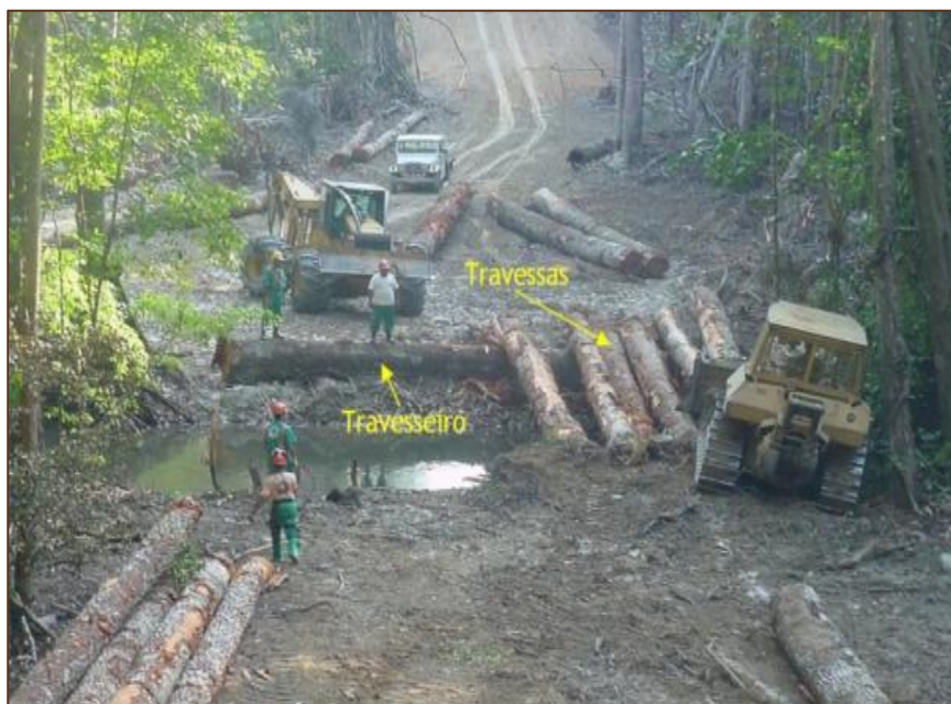
Imagem 18: Início da construção de uma ponte. Fonte: IFT(2008).
