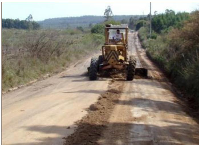
Imagem 5: Abaulamento da estrada com motoniveladora.
