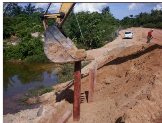
Imagem 21: Escavadeira colocando as estacas que servirão de apoio para as pranchas.
