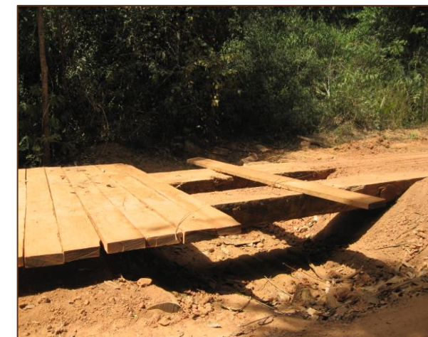
Imagem 23: Pontilhão em construção.
