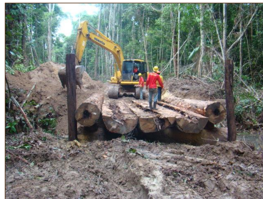
Imagem 19: Pontaletes instalados nas extremidades da ponte.
